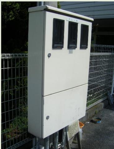
屋外制御盤。設置後約10年経過していて盤の表面が白く粉を吹き、風化している。
